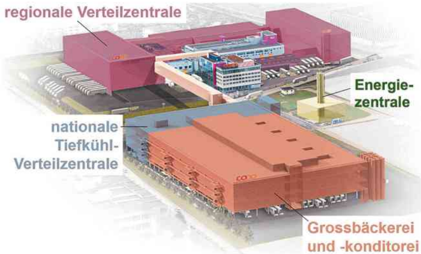
Bild 8: Verteilzentrum und Grossbäckerei Coop in Schafisheim mit Energiezentrale. (Weinhofer et al. 2016 in [1])
