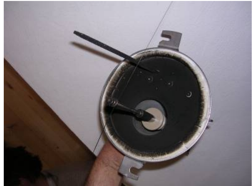
Russablagerung Filtereinsatz Beispiel Trub
